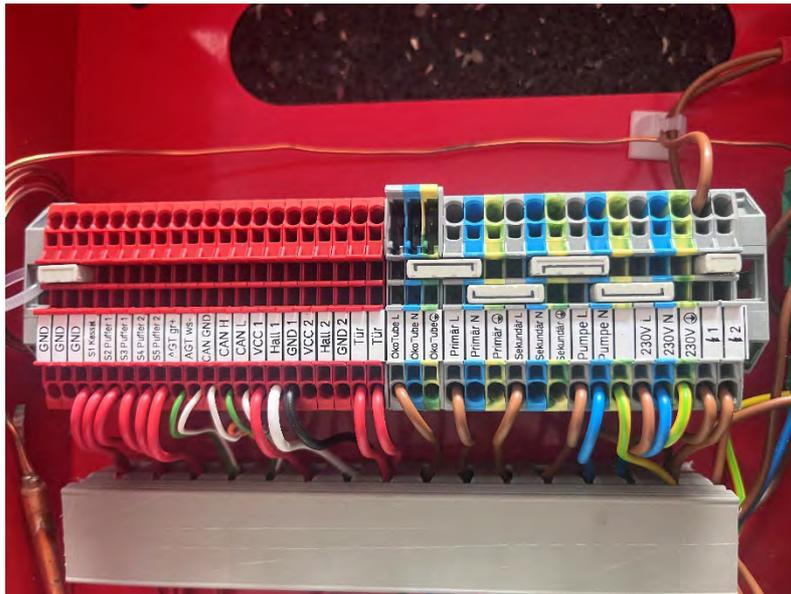
Schließen Sie Kabel entsprechend der Abbildung an den Regler an (von rechts nach links)
